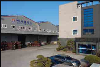
가공 제 1 공장
