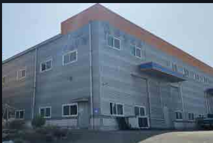
가공 제 2 공장
